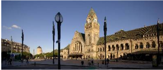
Gare SNCF (Metz)
